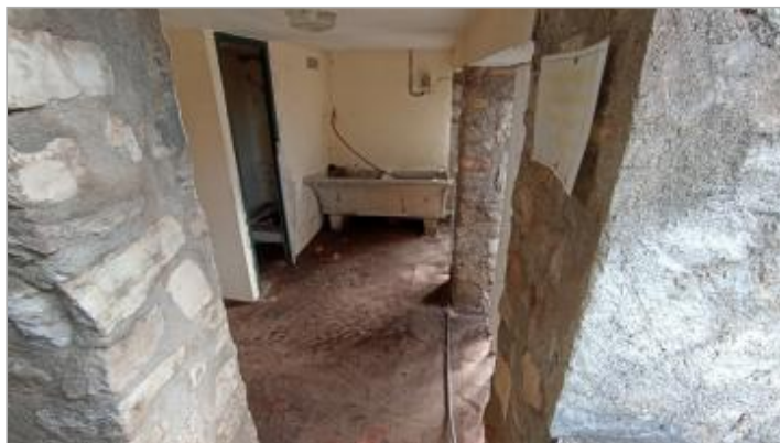
Vue du site, auteur: OTEIS, 2023
