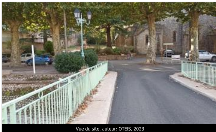
Vue du site, auteur: OTEIS, 2023
