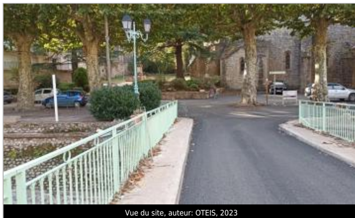
Vue du site, auteur: OTEIS, 2023
