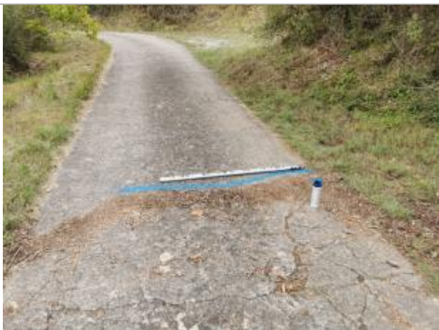
Vue du repère, auteur: OTEIS, 2023
