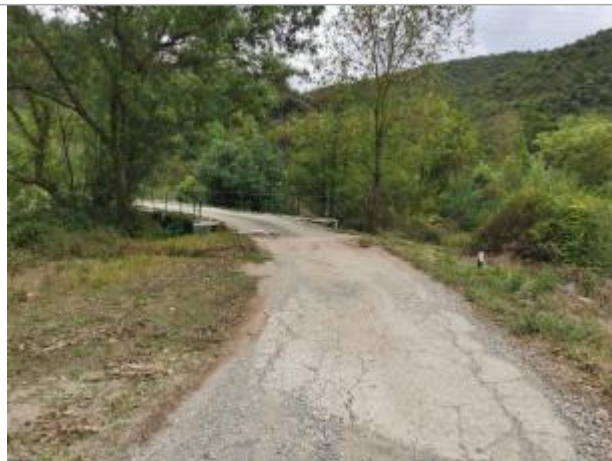
Vue du site, auteur: OTEIS, 2023
