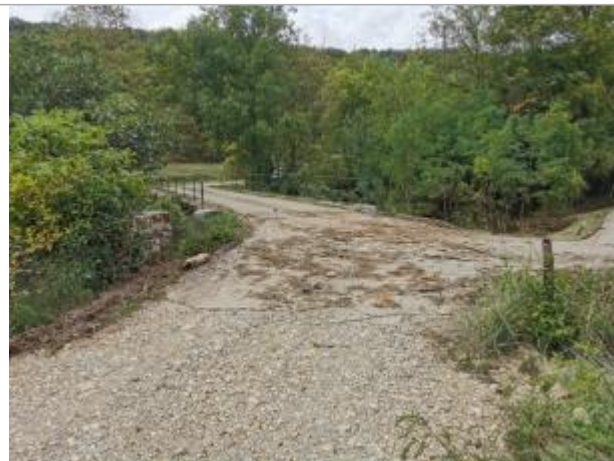
Vue du site, auteur: OTEIS, 2023
