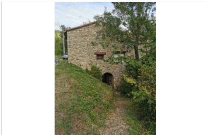
Vue du site, auteur: OTEIS, 2023
