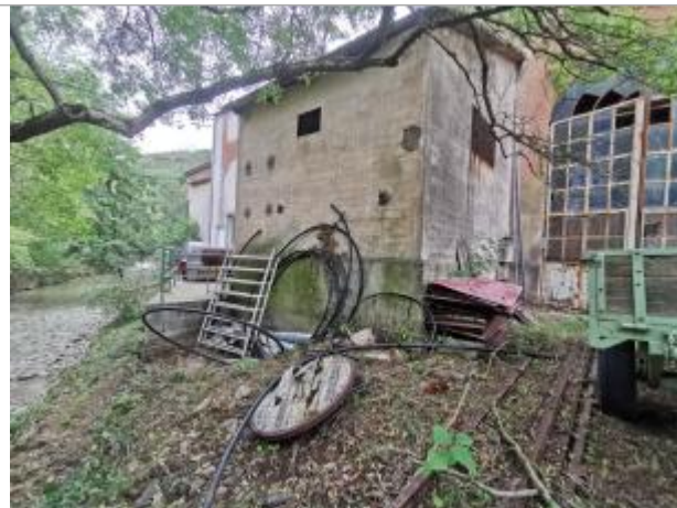
Vue du site, auteur: OTEIS, 2023
