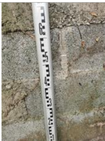
Vue du repère, auteur: OTEIS, 2023
