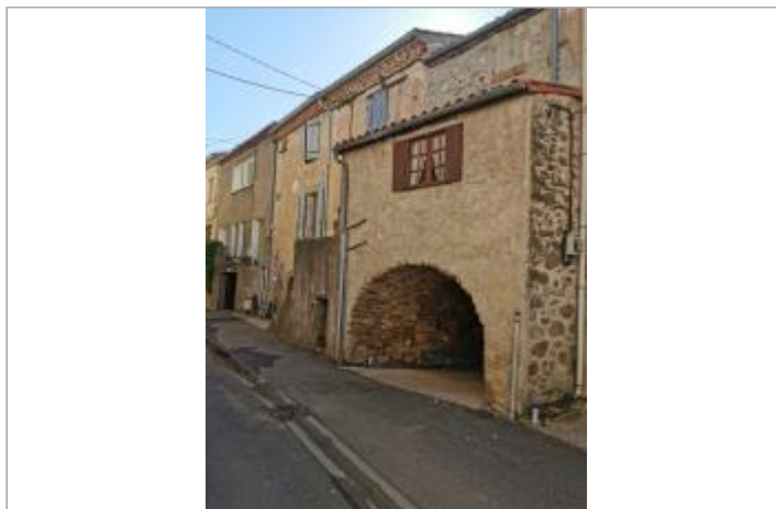
Vue du site, auteur: OTEIS, 2023
