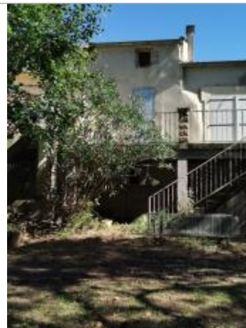
Vue du site, auteur: OTEIS, 2023
