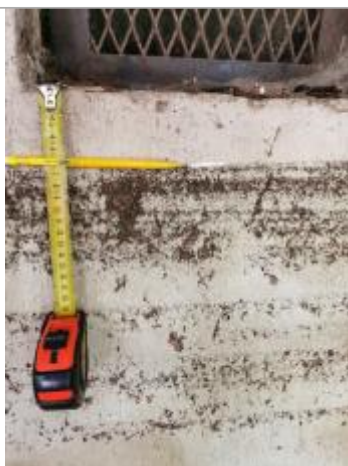
Vue du repère, auteur: OTEIS, 2023
