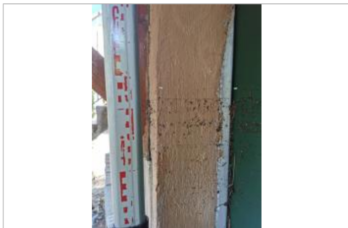
Vue du repère, auteur: OTEIS, 2023
