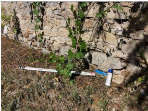
Vue du repère, auteur: OTEIS, 2023
