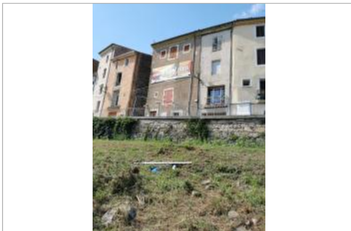
Vue du site, auteur: OTEIS, 2023
