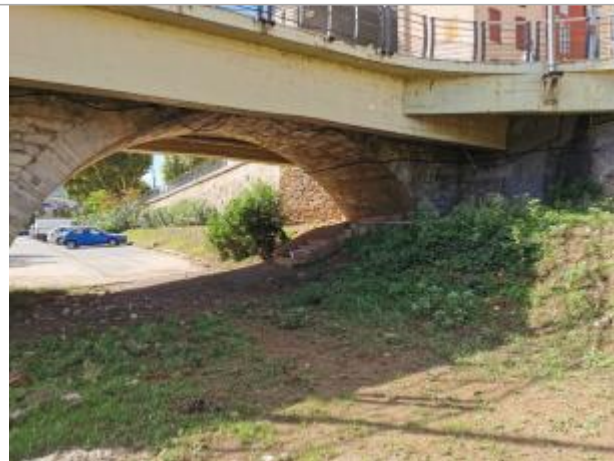
Vue du site, auteur: OTEIS, 2023
