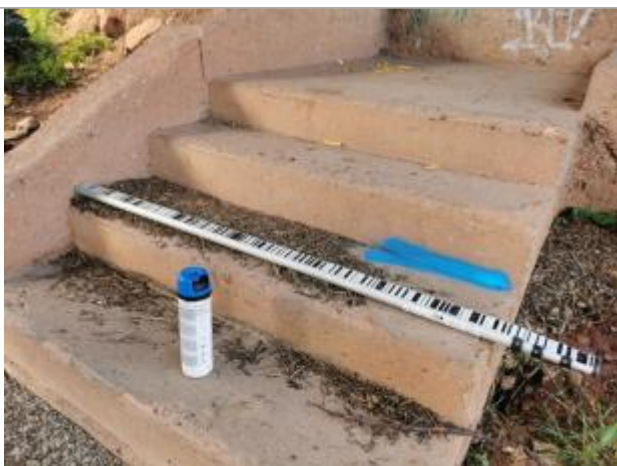
Vue du repère, auteur: OTEIS, 2023
