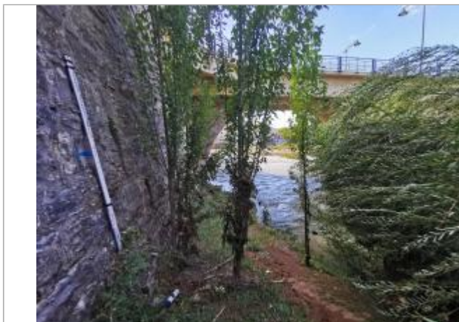
Vue du site, auteur: OTEIS, 2023
