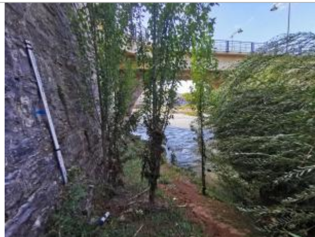
Vue du site, auteur: OTEIS, 2023
