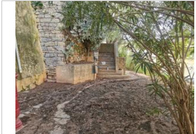
Vue du site, auteur: OTEIS, 2023
