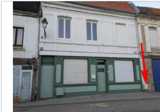
façade et compteur
