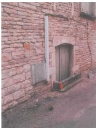
Photo de site (La flèche indique le point de nivellement de référence).
