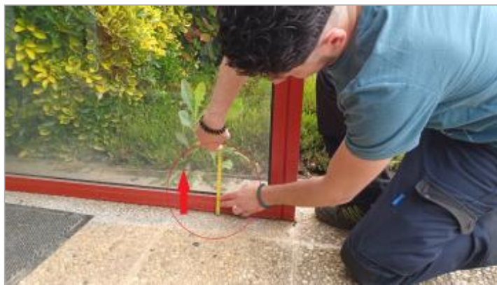
Laisse de crue à 14.5 cm/dalle
