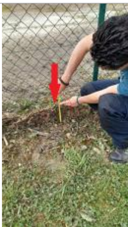
laisse de crue à 20 cm/sol
