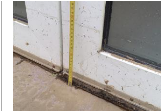
19 cm en partant du seuil de porte
