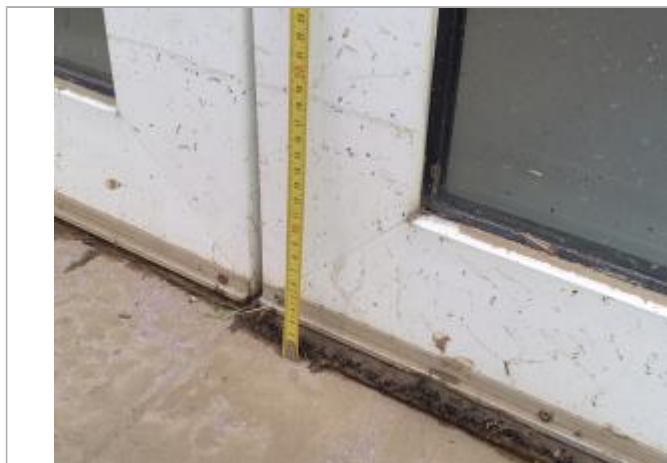
19 cm en partant du seuil de porte
