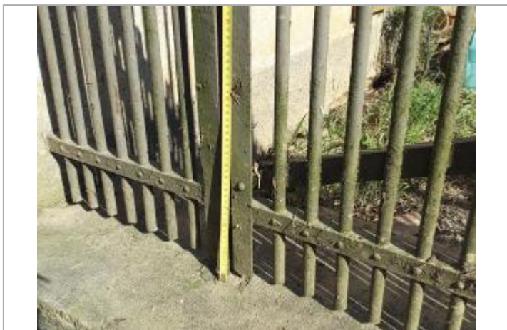
33 cm à partir du seuil en béton
