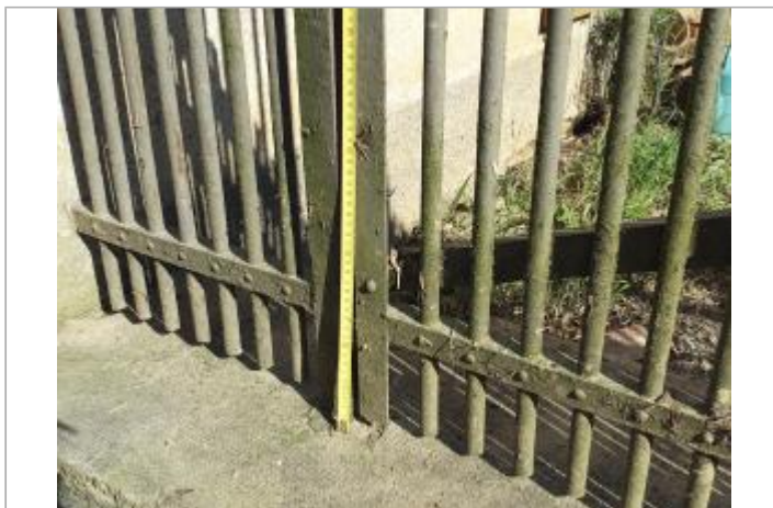
33 cm à partir du seuil en béton
