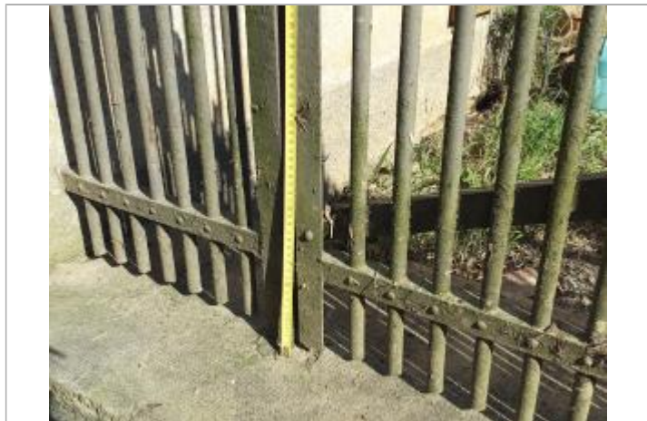
33 cm à partir du seuil en béton
