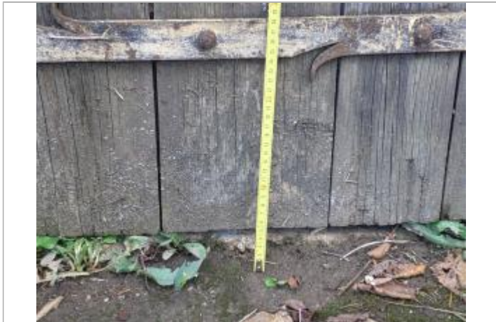
Porte - 22 cm à partir du sol
