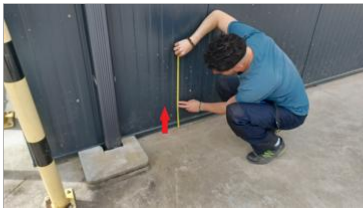
laisse de crue à 25.5 cm/sol
