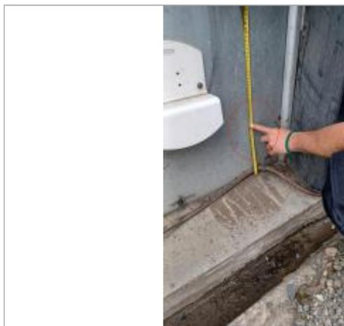
Laisse de crue à 24 cm/ dalle béton
