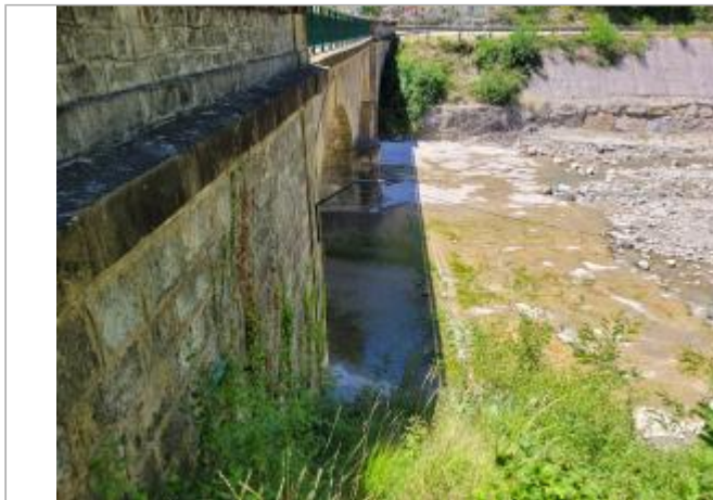
Rive droite, à l'aval du pont de la RD61 rejoignant la RD94.
