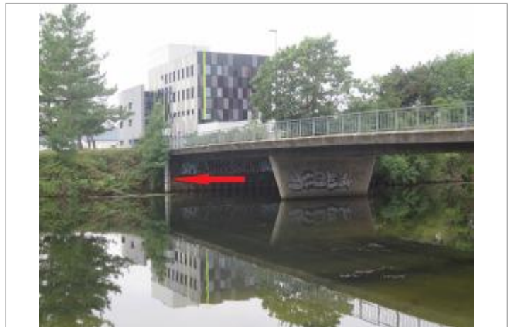
Vue générale à l'amont du pont du chemin de baud (ancienne station limnimétrique)
