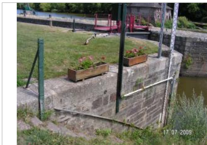
Echelle limnimétrique sur bajoyer aval de l'écluse du Boel
