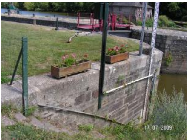
Echelle limnimétrique sur bajoyer aval de l'écluse du Boel
