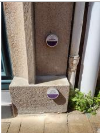
Repère de submersion - Tempête Céline 28 octobre 2023
