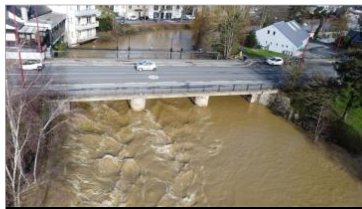
Vue aérienne du pont de la rue de Paris, vue de l'aval - photo CEREMA Ouest
