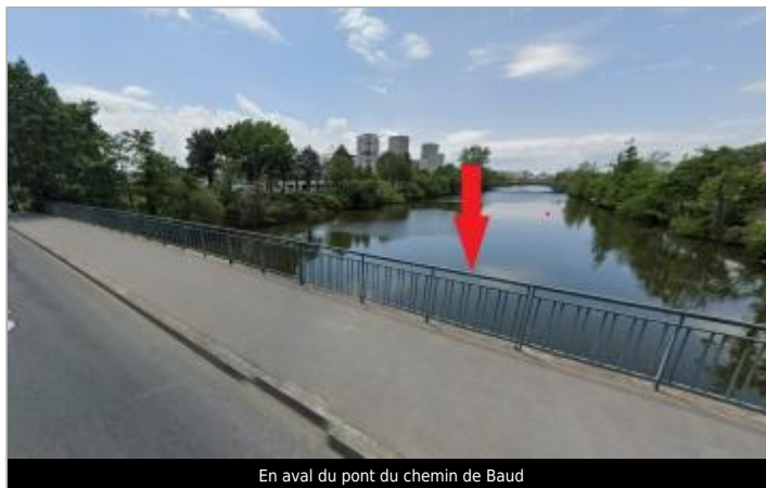
En aval du pont du chemin de Baud
