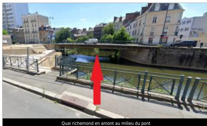
Quai richemond en amont au milieu du pont
