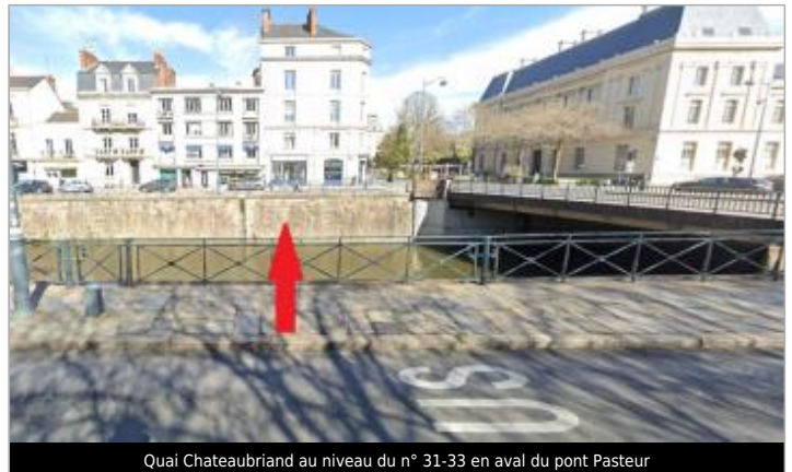
Quai Chateaubriand au niveau du n° 31-33 en aval du pont Pasteur
