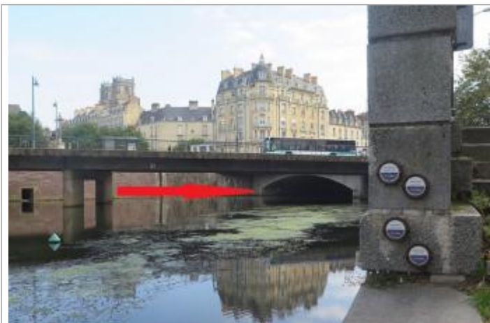
Repères de crues quai de la Prévalaye et pont de la Mission
