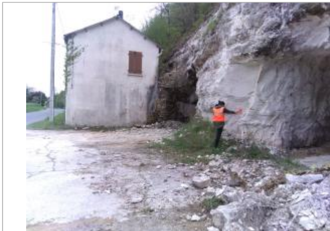
Vue du site - Auteur : SPC LACI
