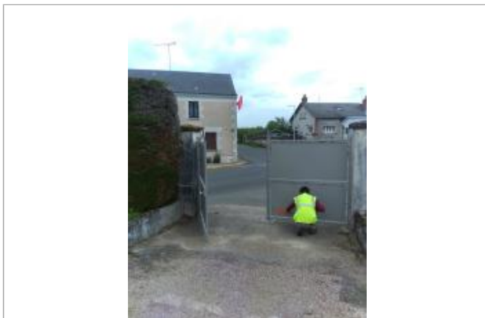
Vue du site - Auteur : SPC LACI
