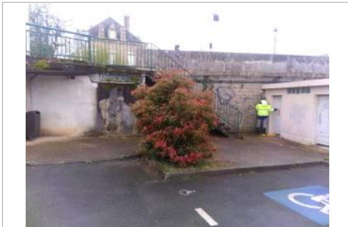
Vue du site - Auteur : SPC LACI
