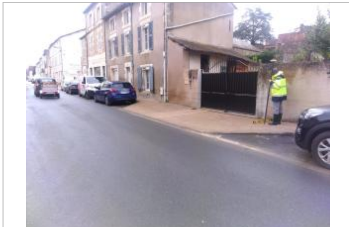
Vue du site - Auteur : SPC LACI
