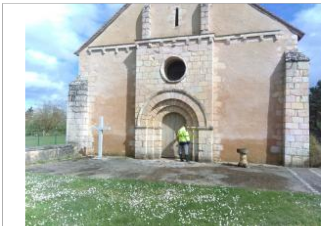
Vue du site - Auteur : SPC LACI
