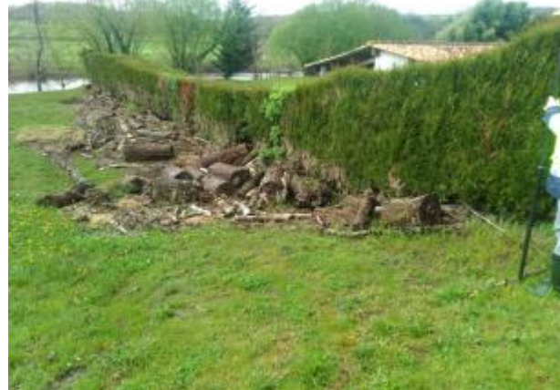
Vue du site - Auteur : SPC LACI
