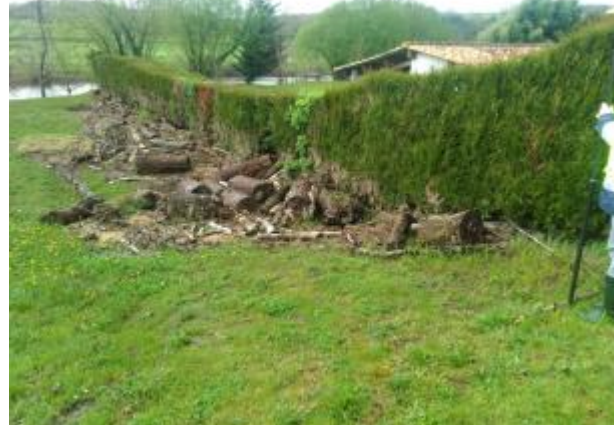
Vue du site - Auteur : SPC LACI
