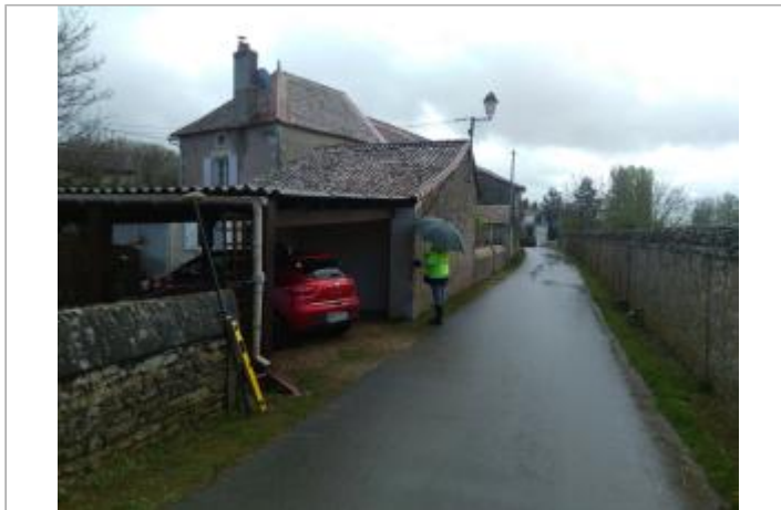
Vue du site - Auteur : SPC LACI
