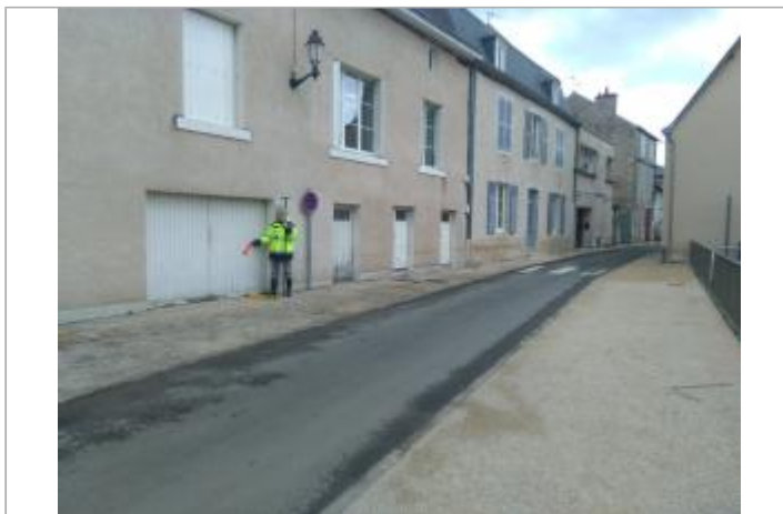
Vue du site - Auteur : SPC LACI
