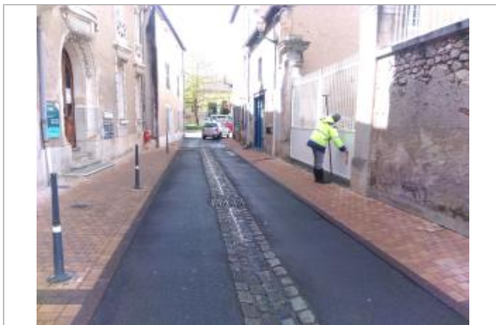
Vue du site - Auteur : SPC LACI
