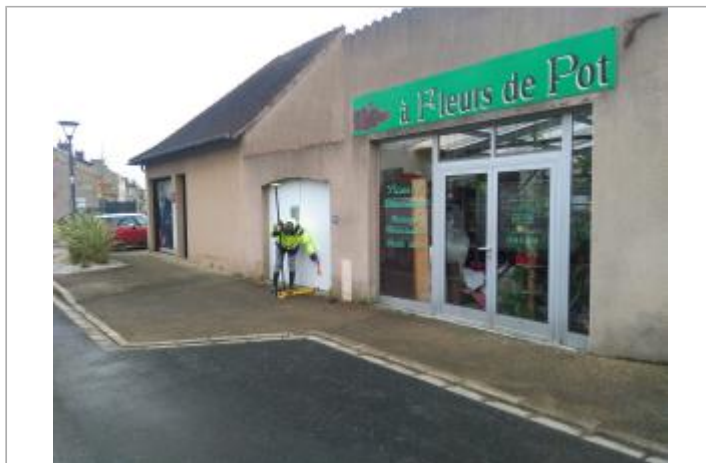
Vue du site - Auteur : SPC LACI
