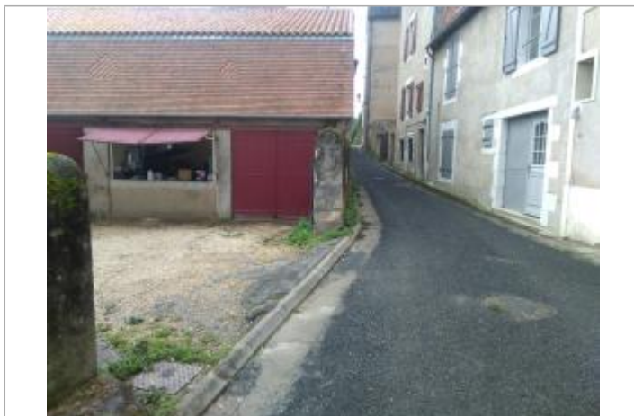
Vue du site - Auteur : SPC LACI
