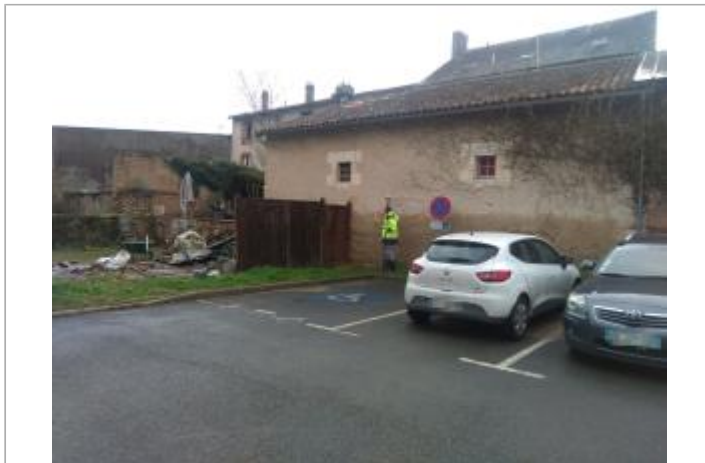
Vue du site - Auteur : SPC LACI
