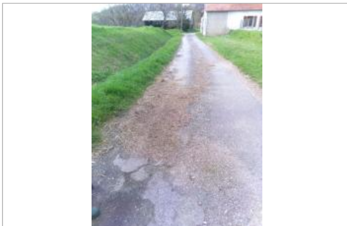
Vue du site - Auteur : SPC LACI
